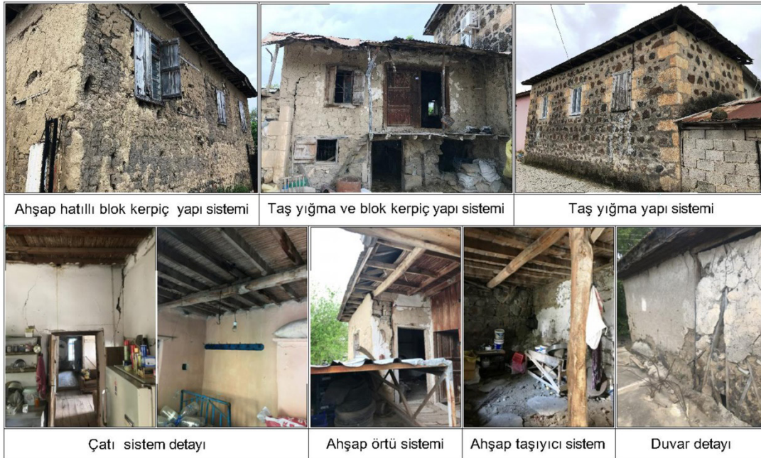
Şekil 10. Burhanlı Köyündeki Konutların Yapım Sistemleri ve Malzemeleri (Y. Gögebakan arşivi)
