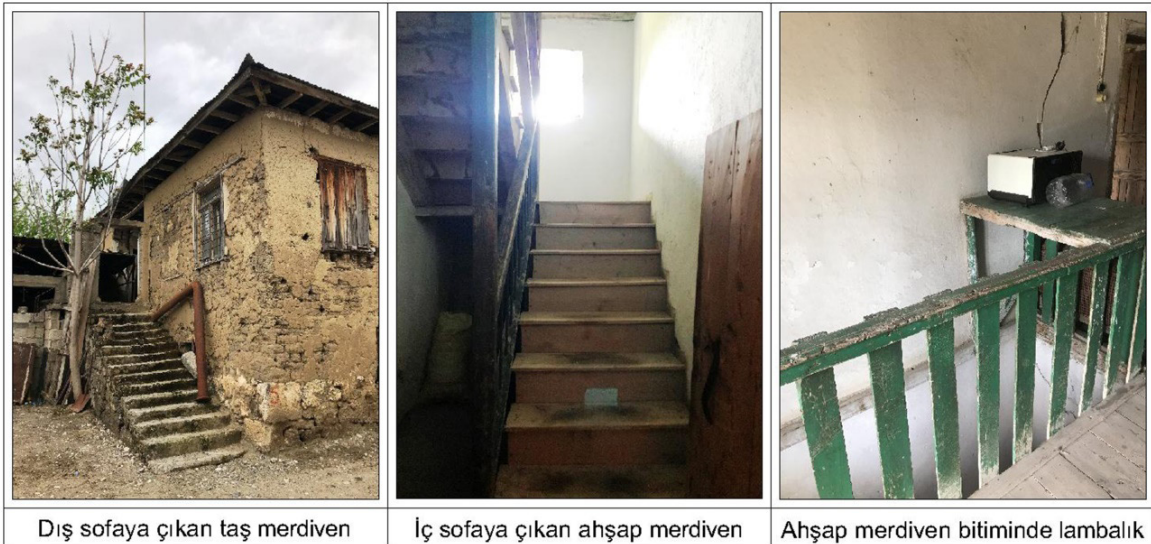
Şekil 9. Yörük Evinde Merdiven Detayı (Y. Gögebakan Arşivi)
